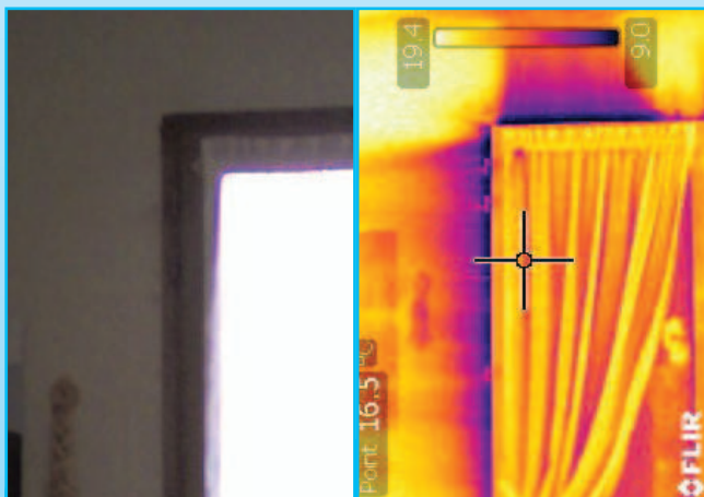
Exemple de menuiserie mal posée, l'air qui s'infiltré est à environ 10°C et l'air intérieur à 18°C.
