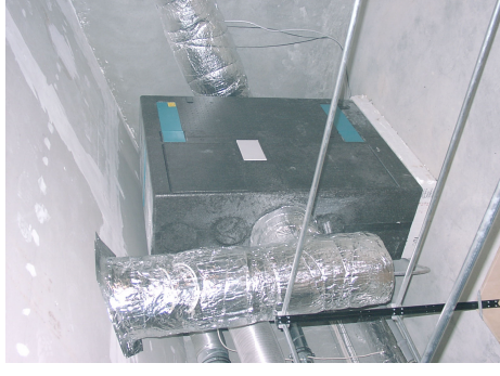
Figure 10 : Système de ventilation ayant un récupérateur de chaleur (rendement de 78%) et une faible consommation d'électricité – mesurés sur le terrain [2].
