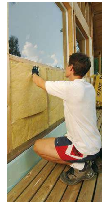
La laine de verre Isover est placée entre les éléments d'une structure en bois, de manière jointive.
