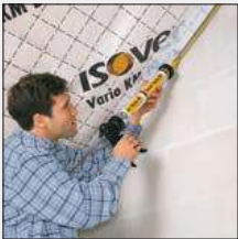
Étanchéité à l'air
