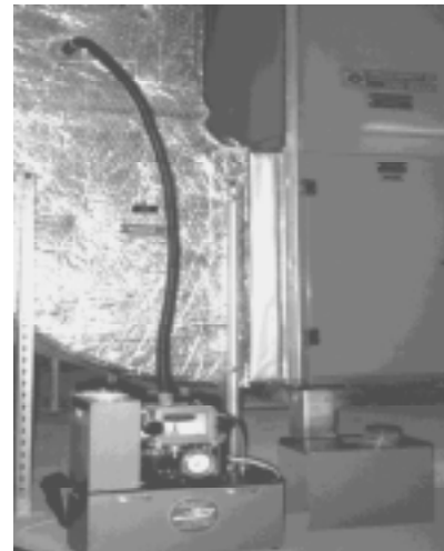
Abb. 7: Probenahme in der Erdregisterluft mit einer Schlauchverbindung zum Slit-Sampler
