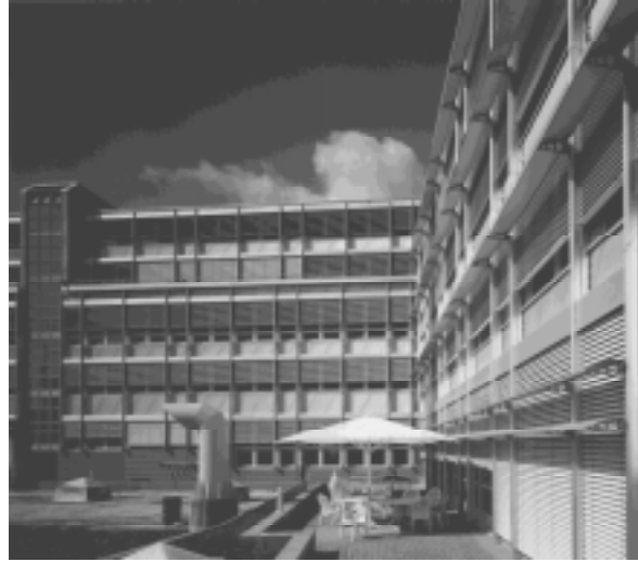
Gewerbehaus Schwerzenbacherhof, Schwerzenbach
